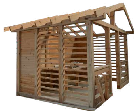
Каркас беседки по типовому проекту «Лето»
