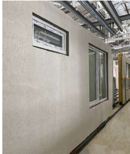
Наружная стеновая панель с фасадом из декоративной штукатурки
