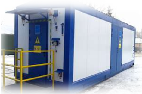
Блок-контейнеры электропитания БК (УГП)
