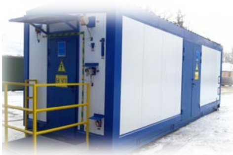
Блок-контейнеры электропитания БК (УГП)
