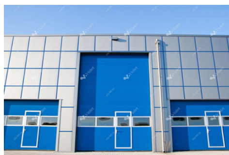
Фиброцементные панели для наружной отделки фасадов
